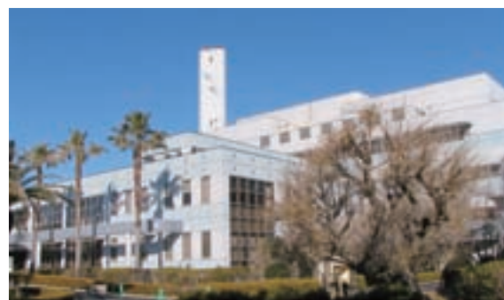
浦安市廃棄物処理施設 外観
